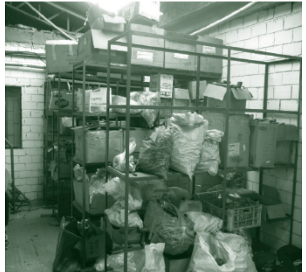
Foto 6. Material combustible en zonas de almacenamiento
